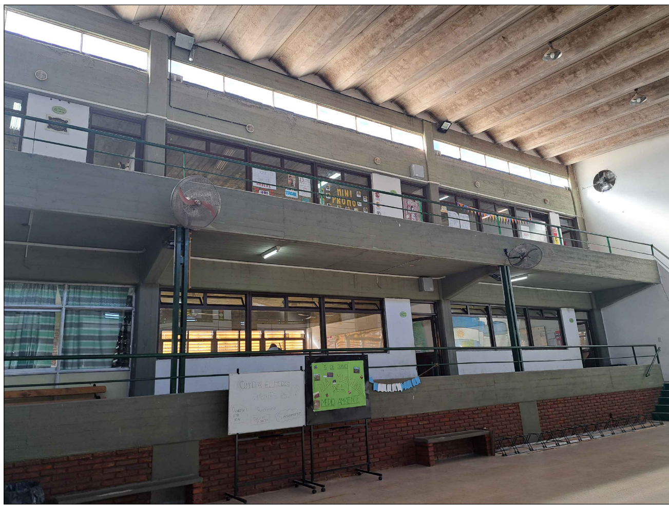
FOTO 1 DISEÑO Y FORMA DE COLUMNAS METALICAS A UTILIZAR EN GALERIA DE LAS 2 AULAS NUEVAS S/PROYECTO.
